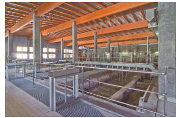
Kläranlage Abbildung (Foto ARA Pustertal AG)
