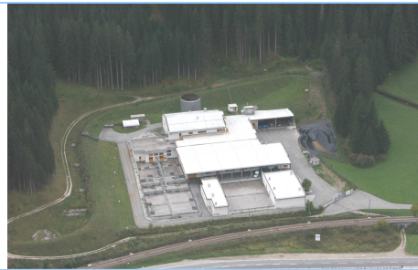
Kläranlage Abbildung (Foto ARA Pustertal AG)
