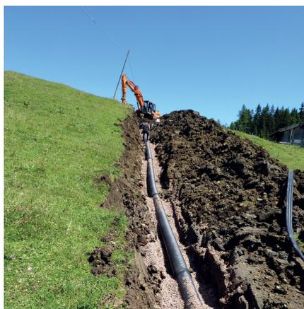
Foto 1: Bau der Hauptkanalisation Seiser Alm – Seis
