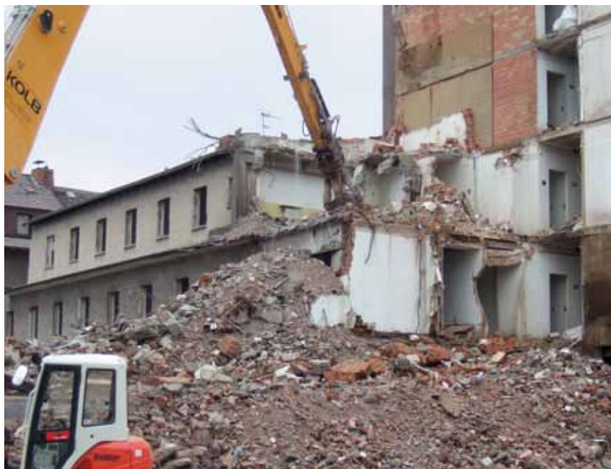
Abb. 3 Rückbau eines entkernten Gebäudes
