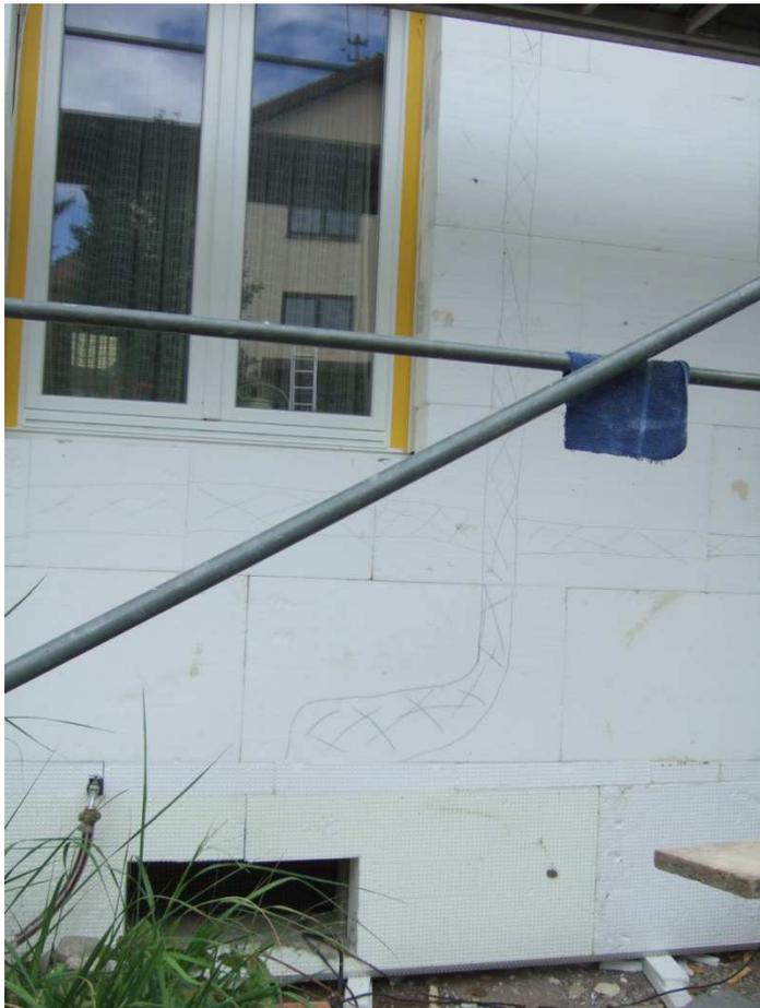
Abb. 13: Außenwanddämmung mit Polystyrol
