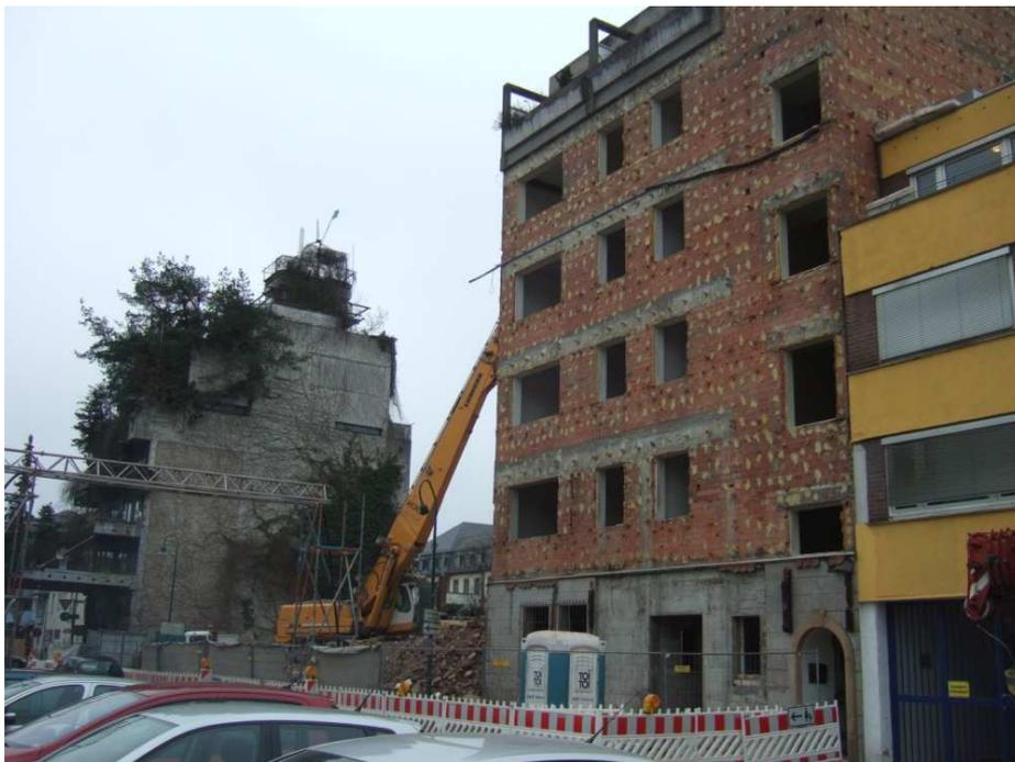
Abb. 17: Massive Ziegelmauerwand mit Resten von WDVS-Befestigung
