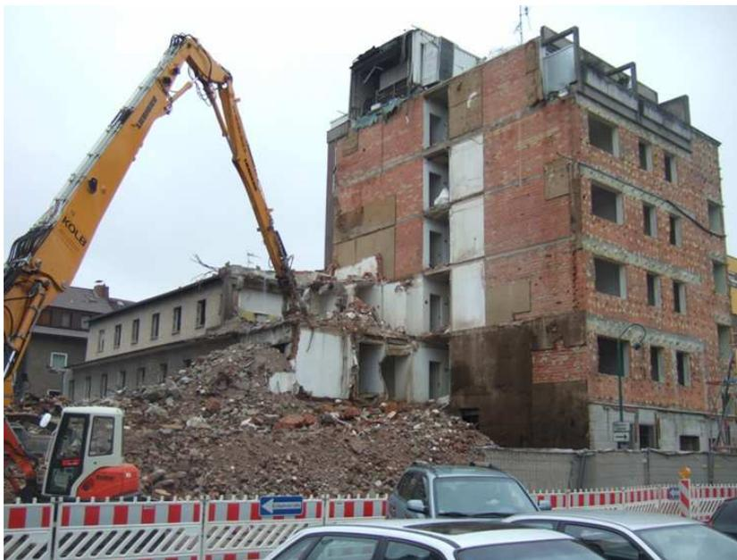
Abb. 26: Beispiel eines Abbruchs nach Entfernung des WDVS
