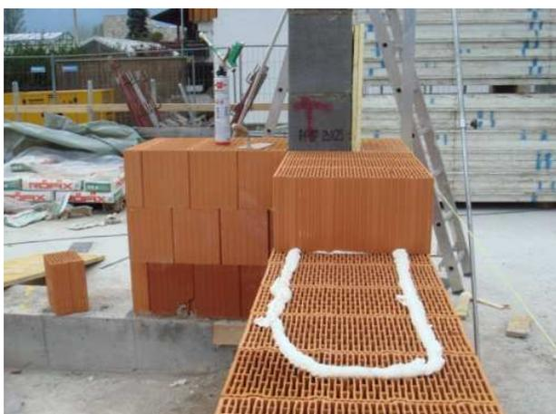
Abb. 5: Hochlochziegel im Einsatz (Amt für Luft und Lärm, Provinz Bozen 2012)
