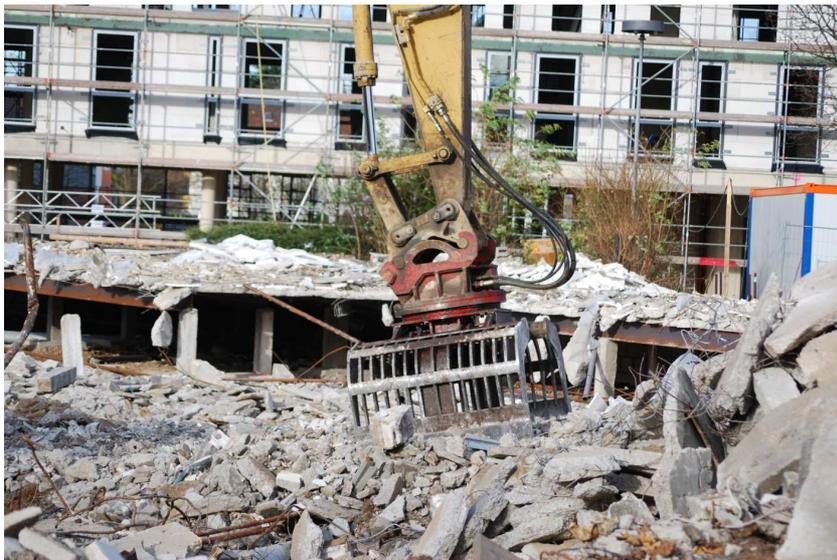
Abb. 15: Beispiel eines Baggers mit Sortiergreifer (pixelio 2012)
