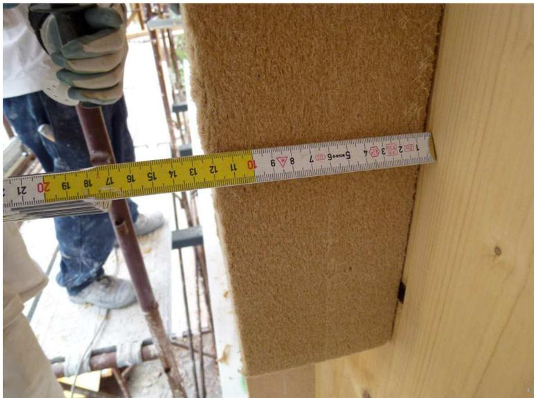
Abb. 14: Außenwanddämmung mit Holzfaserdämmplatten (Amt für Luft und Lärm, Provinz Bozen)
