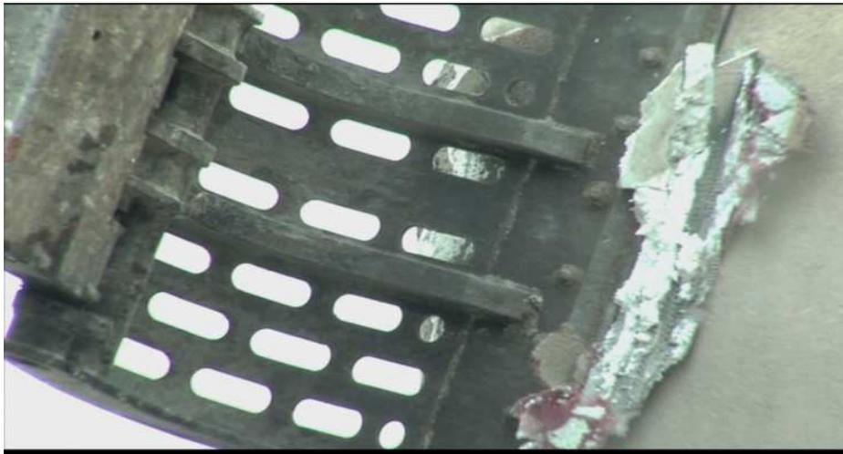
Abb. 16: Einsatz des Sortiergreifers beim Rückbau eines WDV-Systems
