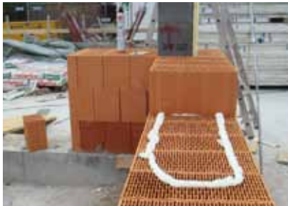
Abb. 4 Hochlochziegel im Einsatz
