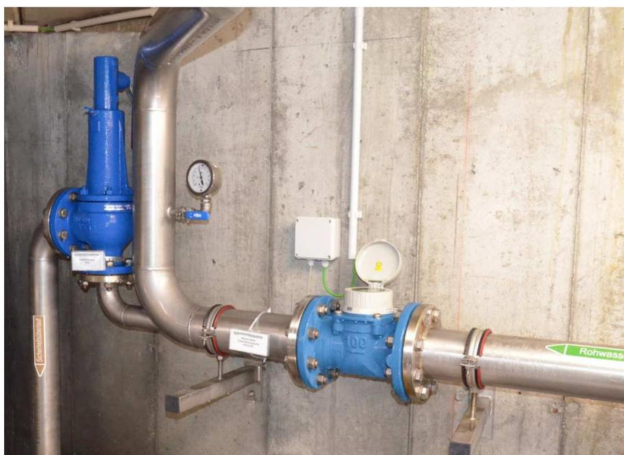
Abbildung 33: Wasserzähler und Sicherheitsventil
