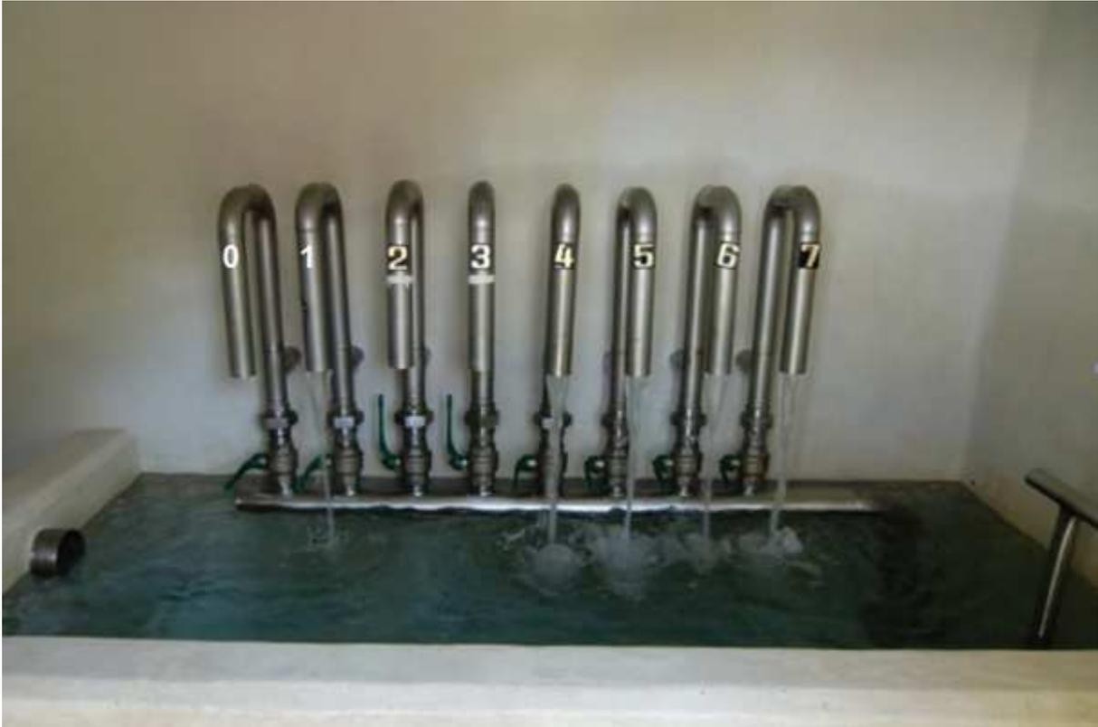
Abbildung 9: Mehrere eindeutig identifizierbare Zuläufe im Sammelschacht
