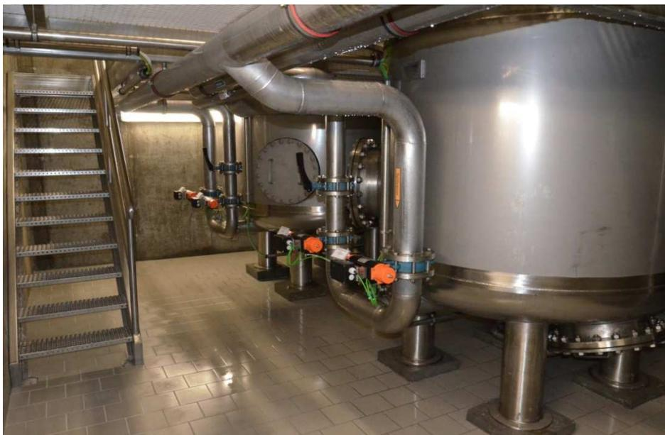
Abbildung 23: Entsäuerungsanlage in Reaktoren
