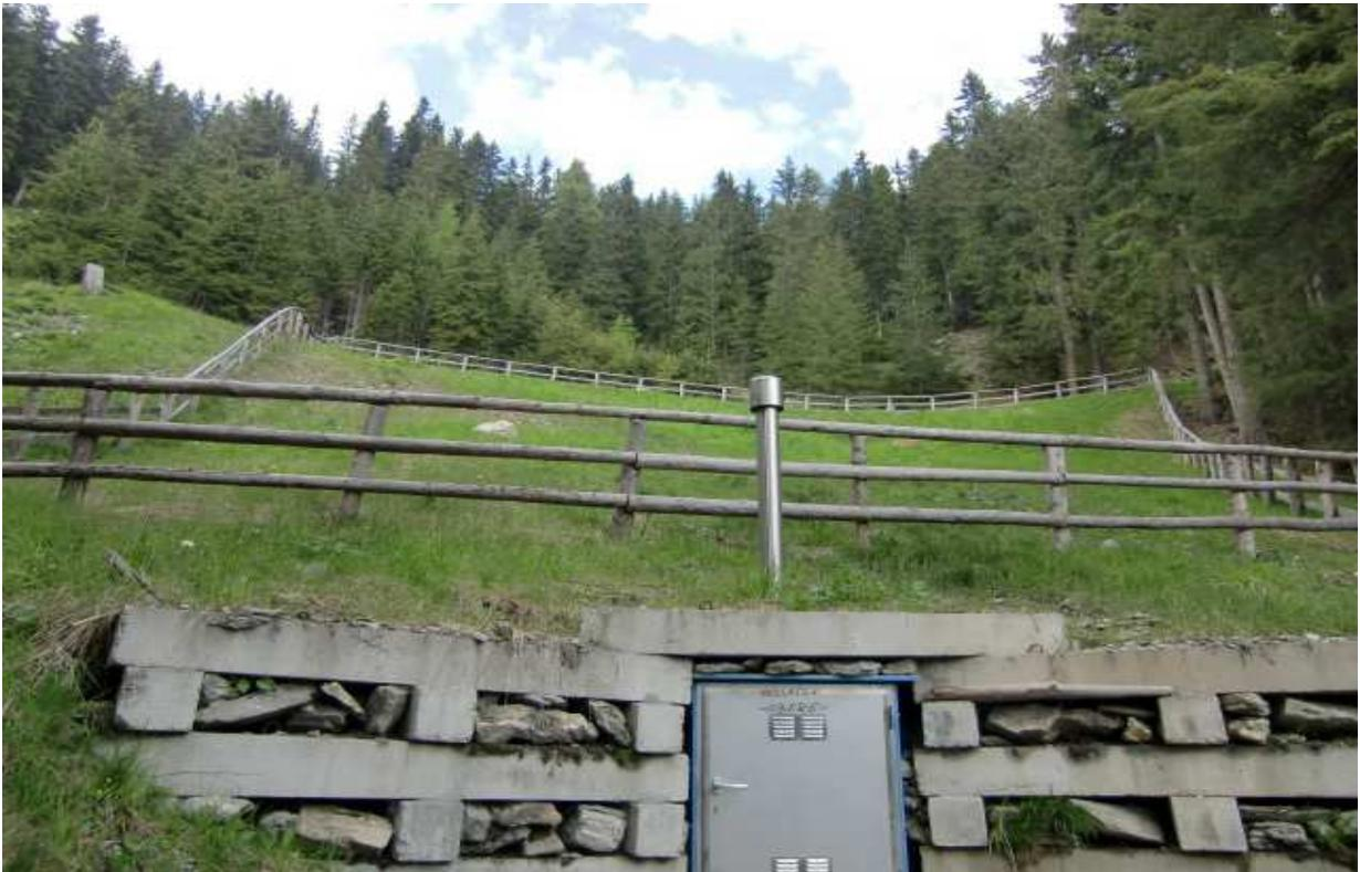
Abbildung 6: Quellfassung mit anschließendem Quellsammelschacht und Entlüftung
