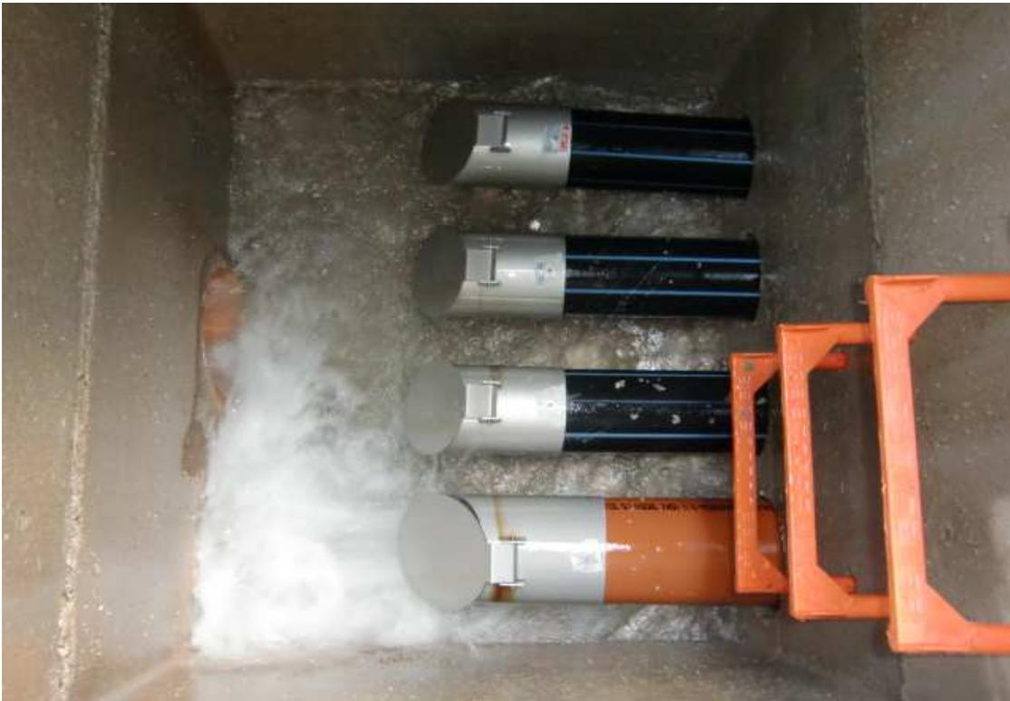
Abbildung 13: Rohre mit Froschklappen geschützt, in einem eigenen Schacht angeordnet
