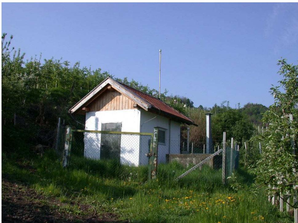
Abbildung 15: Umzäunter Fassungsbereich des Tiefbrunnens mit Abschlussbauwerk
