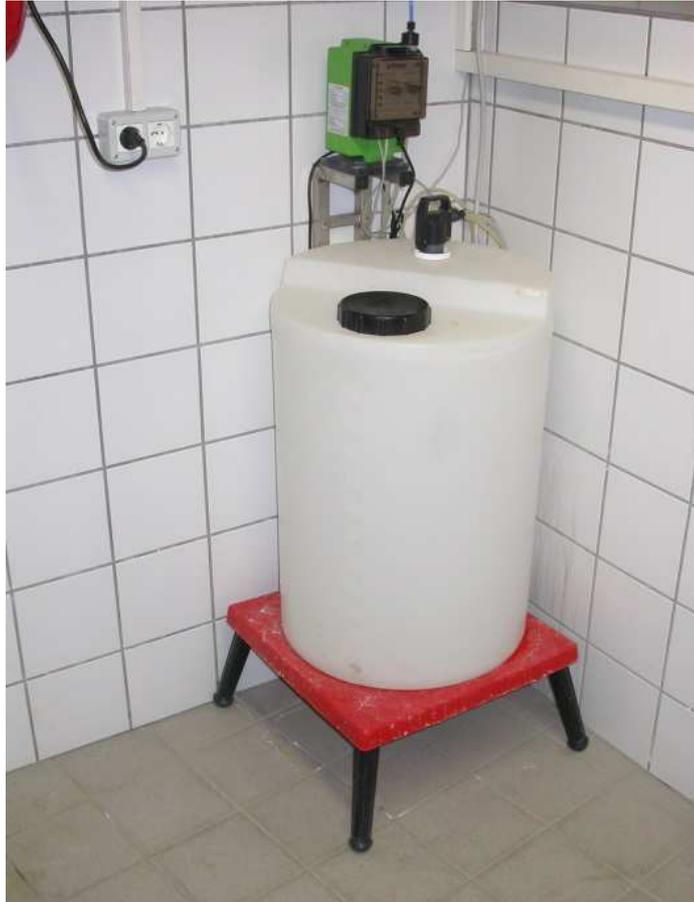
Abbildung 18: Notchlorung mittels Dosierpumpe
