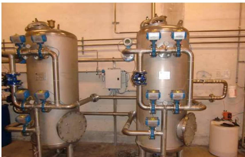
Abbildung 25: Arsenentfernung
