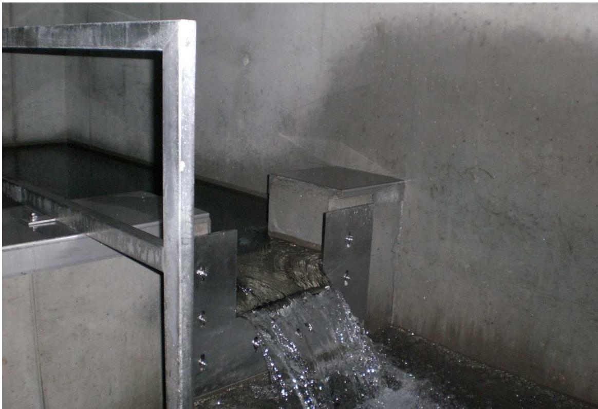
Abbildung 8: Überlauf mit Messwehr vom Beruhigungsbecken in das Entnahmebecken
