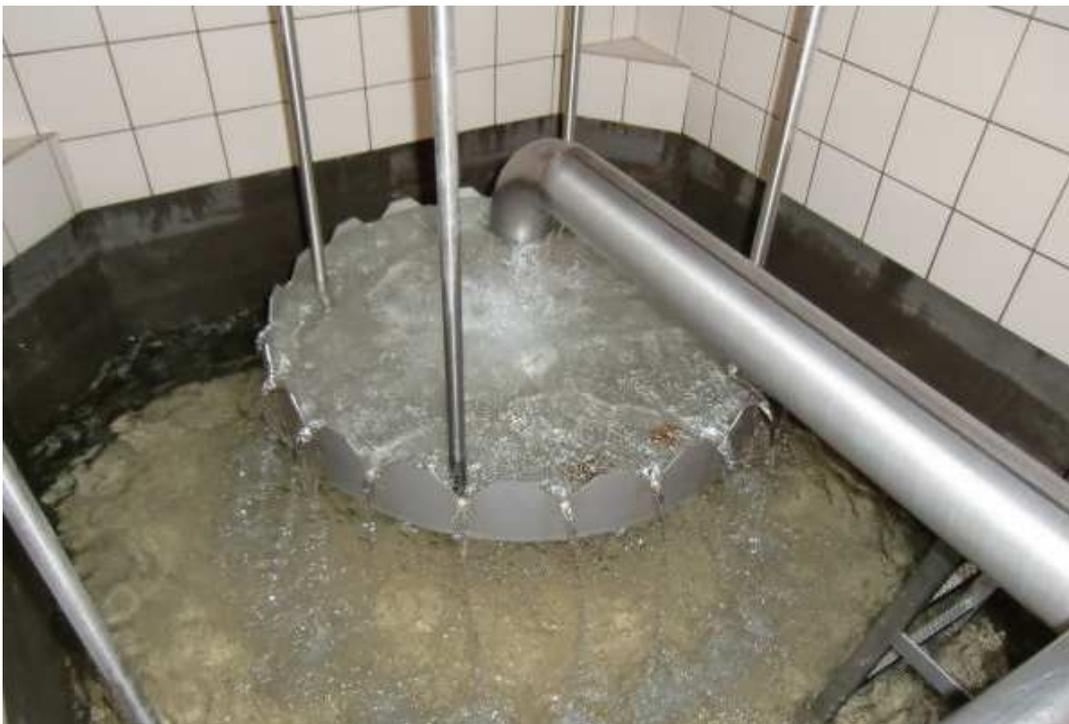
Abbildung 21: Entsäuerung des Wassers mittels Belüftung (Berieselung)
