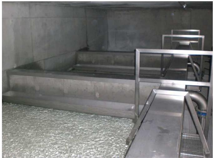
Abbildung 22: Entsäuerungsanlage mit anfänglicher Berieselung (breitflächiger Zufluss) und drei Becken mit Marmorfilter
