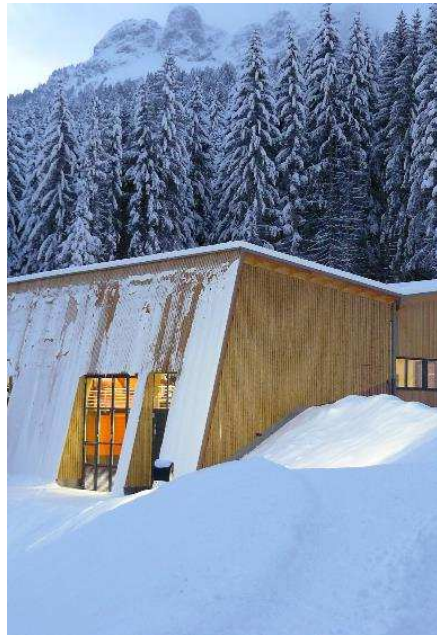
Foto Energie & Fernwärme Obereggen
